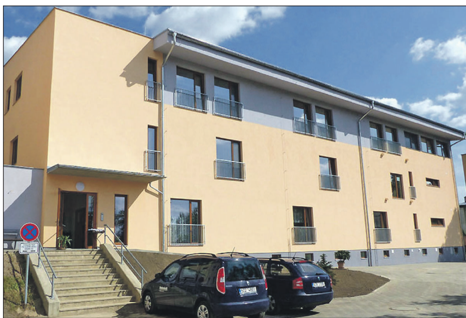
Domov Vyhlídka poskytne ubytování pro dvě desítky obyvatel.
