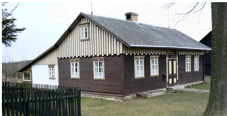
Obr. č. 14: Roubená chalupa na Rejvíze se zdobeným štítem a s okny doplněnými nadokenní a podokenní římsou
