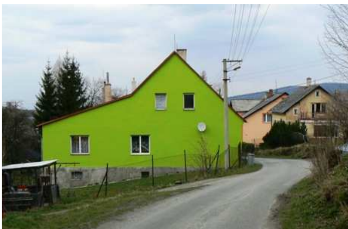
Obr. č. 18: Zářivá fasáda na rekonstruovaném obydlí
