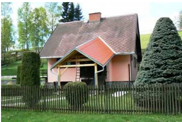
Obr. č. 17: Tzv. „víkendová krajina“ využívaná v rozporu s venkovskou tradicí, nevhodné využití zahrady, pro jesenickou krajinu nevhodné dřeviny a jejich násilná geometrizace, netradiční proporce stavby, přístavba zastřešení vstupu a střešní krytina
