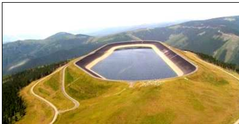
Obr. č. 19: Přečerpávací vodní elektrárna Dlouhé Stráně.
