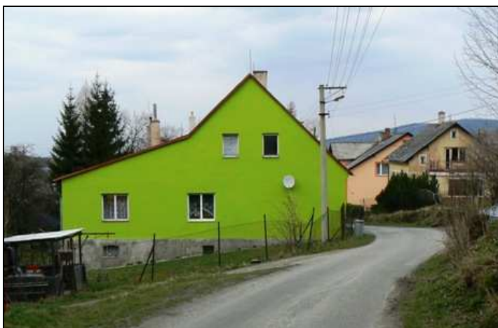
Obr. č. 8: Zářivá fasáda na rekonstruovaném starším obydlí
