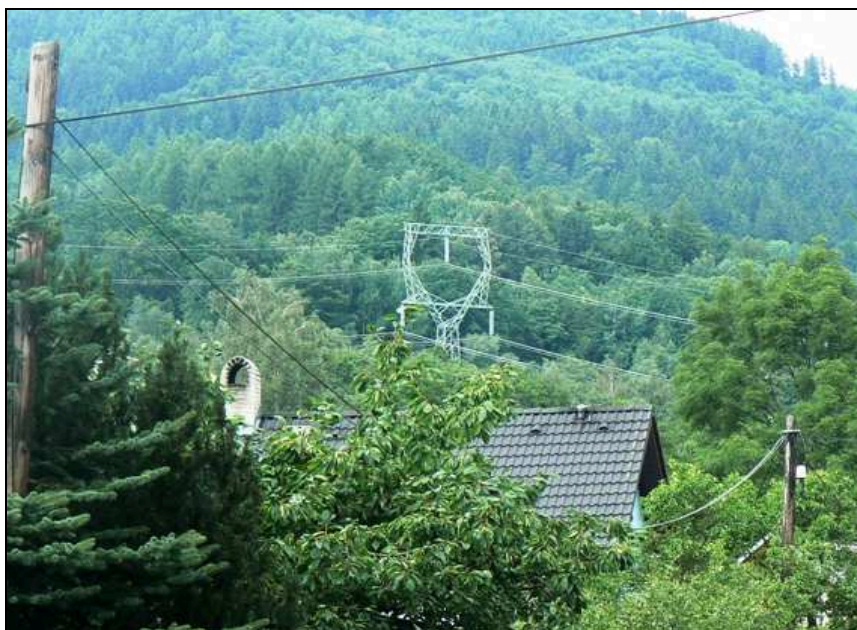
Obr. č. 3: Stožár na trase vedení VVN z PVE Dlouhé Stráně – tvrdá vizuální kontaminace krajiny
