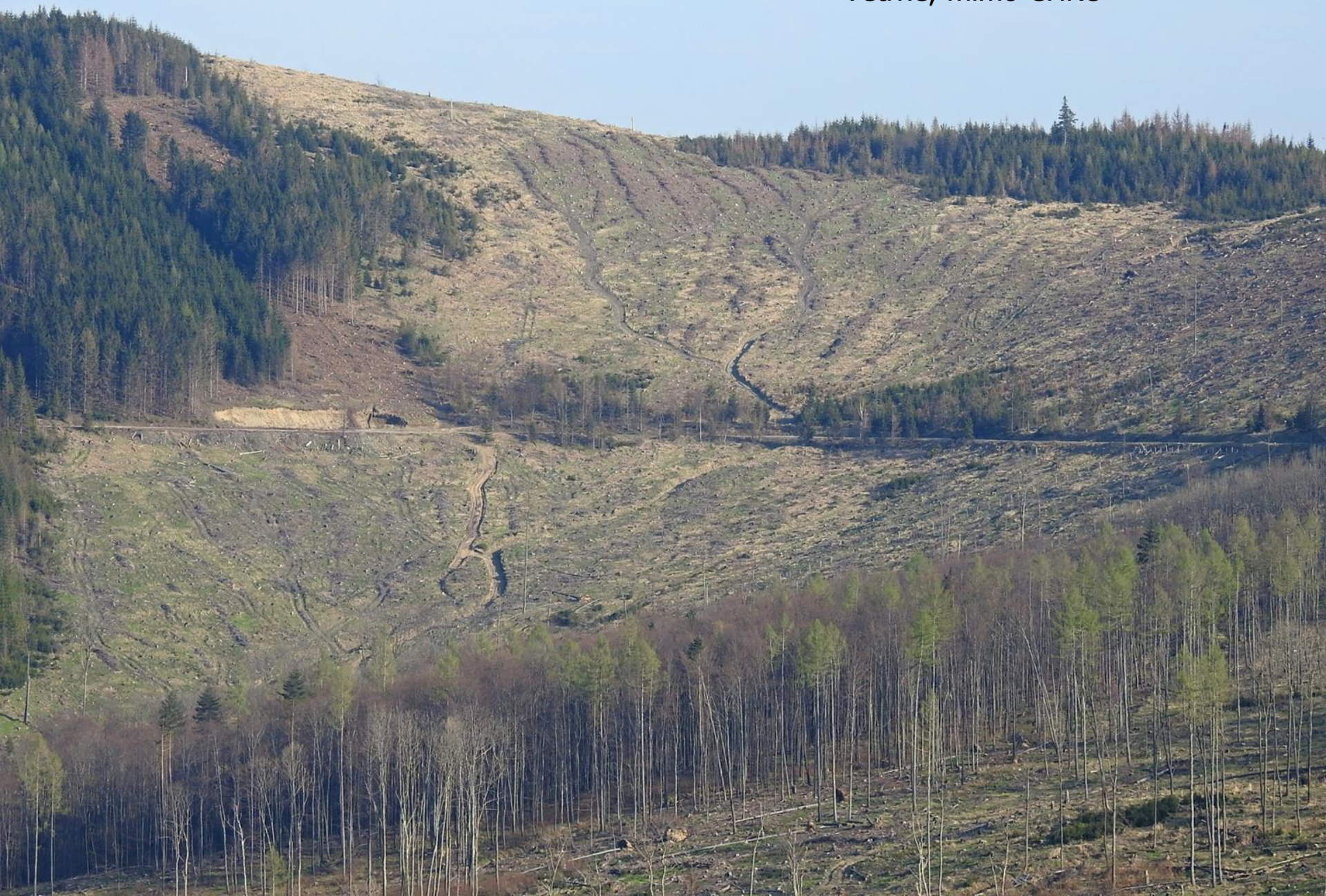
Erozní rýhy na svazích v oblasti Větrné, mimo CHKO
